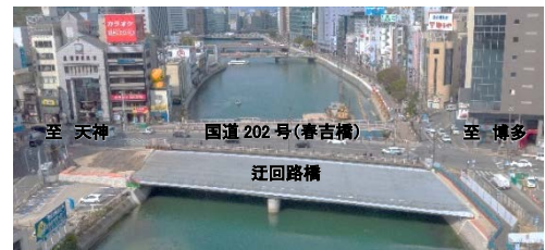
▲迂回路橋が設置された春吉橋（H31.4）
