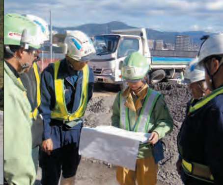
▲ 図面と現場をチェック
