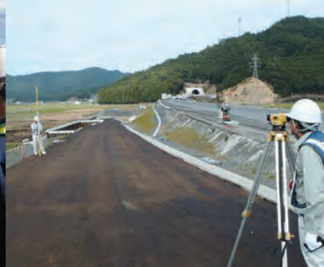
▲ 仕上がり確認のために測量中
