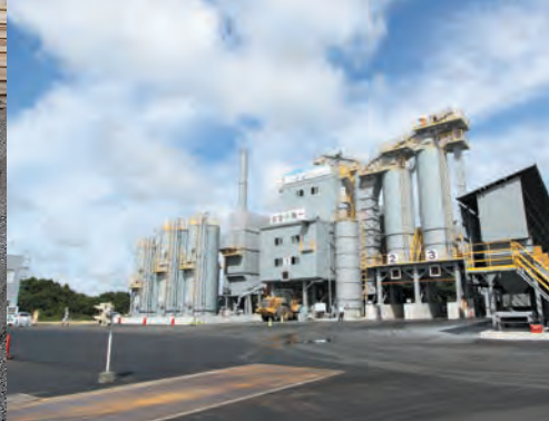
▲アスファルト合材プラント
