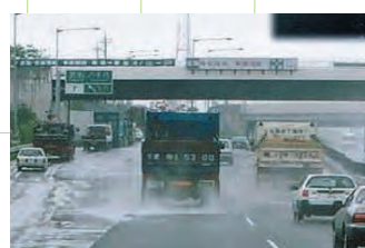
排水性舗装には吸音効果もある
