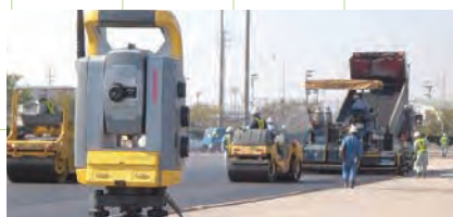
GPSからの位置情報と精密な測量を元に自動制御された重機による精度の高い施工が可能
