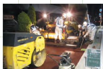
カラー透水性舗装の施工の様子
