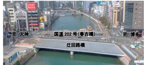
▲迂回路橋が設置された春吉橋（H31.4）
