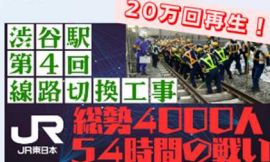
渋谷駅 線路切換工事
