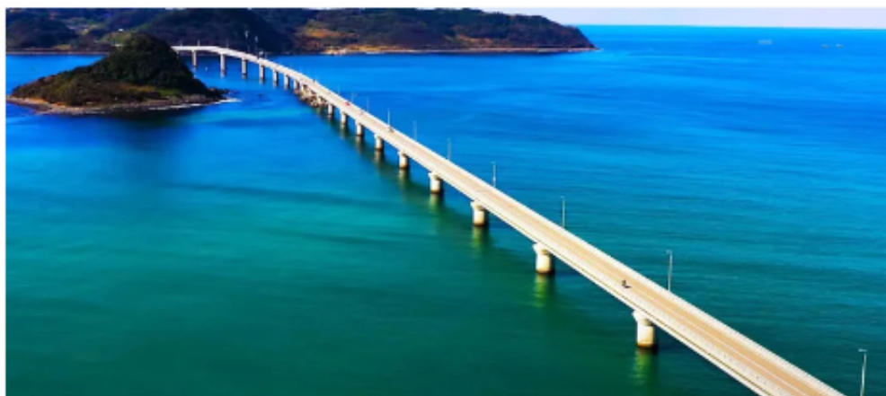
角島大橋（開通：2000年）
