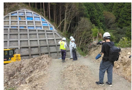
工事現場での撮影風景
